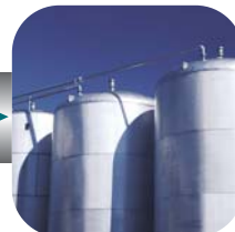
Substancias extrañas dentro de los depósitos de agua.
